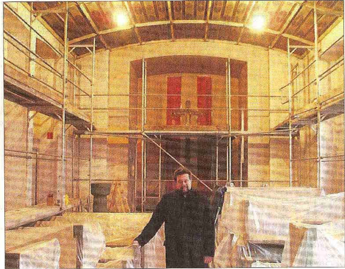
Pfarrer Bodo Meyer im Innenraum der Kreuzkirche. Mit neuem Farbkonzept und neuer Lichtenanlage sollen die „Schätze“ des Gotteshauses besser zur Geltung kommen. (WR-Bilder: Lutz Hesse)
